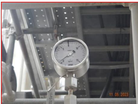
ภาพที่ 2.2-62 อุปกรณ์วัดความดัน (Pressure Indicator) ที่ถังเก็บกาก
