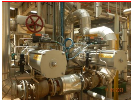
ภาพที่ 2.2-3 ระบบ Instrument Shutdown System (ISD)
