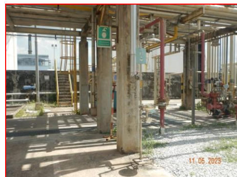
ภาพที่ 2.2-53 อ่างล้างตา ผักบัวล้างตา และที่ชำระล้างฉุกเฉิน
