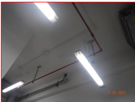
ภาพที่ 2.2-42 ระบบกระจายน้ำดับเพลิง (Fire Water Spray) สำหรับอาคารสำนักงาน ห้องปฏิบัติการวิเคราะห์
