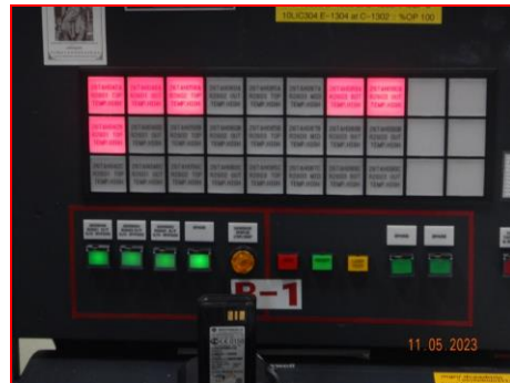
ภาพที่ 2.2-9 Emergency Shutdown Push Button Switch ที่ห้องควบคุมกระบวนการผลิต (Control Room)
