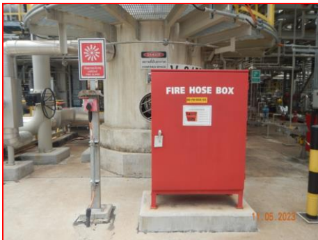
ภาพที่ 2.2-40 ตู้เก็บอุปกรณ์ดับเพลิง
