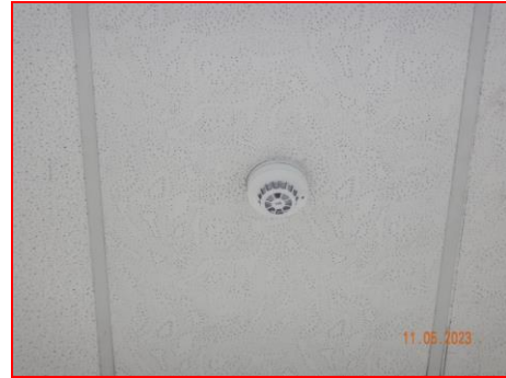
ภาพที่ 2.2-47 Smoke Detector บริเวณอาคารต่างๆ
