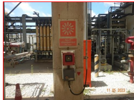
ภาพที่ 2.2-49 Fire Alarm Manual System
