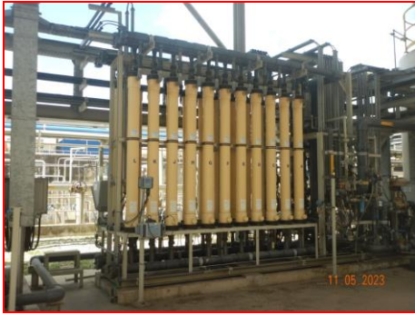
ภาพที่ 2.2-14 ระบบกรองโดยใช้เยื่อเมมเบรน (Ultrafiltration)
