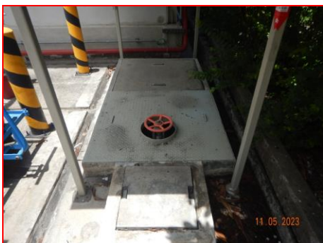
ภาพที่ 2.2-28 บ่อ (Sump) รวบรวมสารเคมีที่อาจหกั่วไหล
