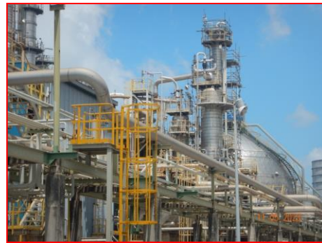
ภาพที่ 2.2-59 ท่อส่งไอสารส่วนเกินที่หอเผา (Flare)
